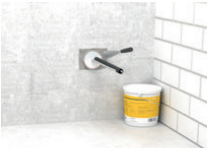
Подгонка и установка заглушки из пеноматериала в отверстие с помощью ножа и герметизация поверхностей от проникновения дыма с помощью состава ASX.
