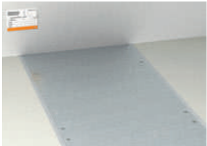
Невидимая проходка в каналах под бесшовным полом.
