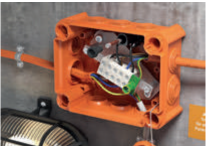
Ввод кабеля с помощью уплотнителей.
