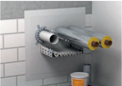
С обеих сторон с помощью шпилек зафиксировать манжеты для труб из горючих материалов.
