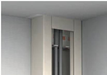
Крепежный уголок, предотвращающий соскальзывание при вертикальном расположении.
