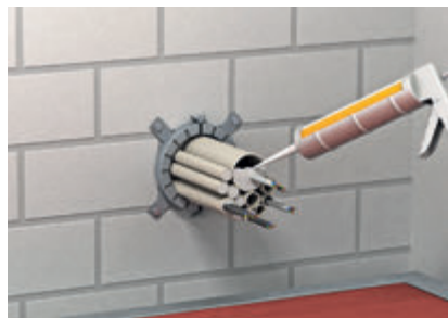
Заполнение концов труб огнестойким защитным средством DSX.
