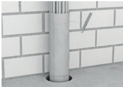
Фиксация бандаж с помощью проволоки.
