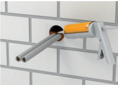
Заполнение отверстия шпатлевкой FBA-SP.
