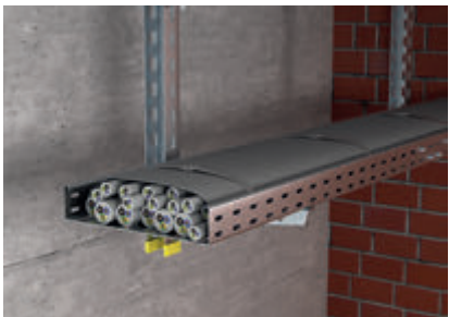
Бандажирование кабельного пучка на несущих системах.
