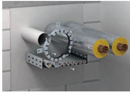
На трубы из полимерных материалов с обеих сторон стены установить противопожарные манжеты
