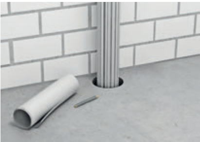
Подготовка кабельной проходки.
