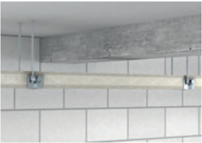
Подвесной монтаж на соединительных элементах.
