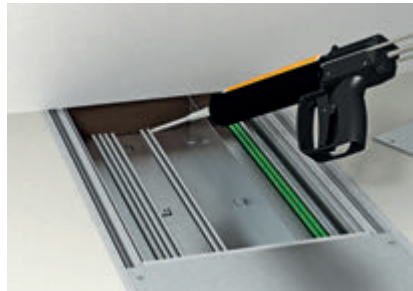
Нанесение огнестойкой пены непосредственно под стену.
