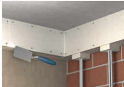
Завершающая обработка поверхности: нанесение краски или шпатлевки.
