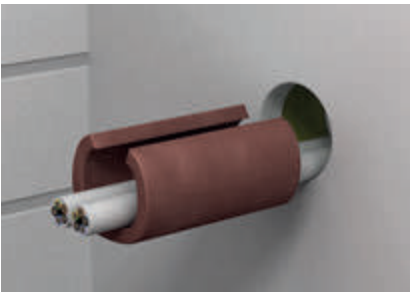
Если кабель уже проложен, необходимо надрезать огнестойкую оболочку.
