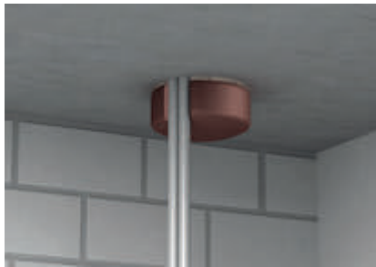
Вырезка и монтаж заглушки в перекрытие.
