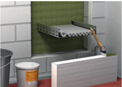
Нанести покрытие на торцы минеральной ваты для приклеивания.
