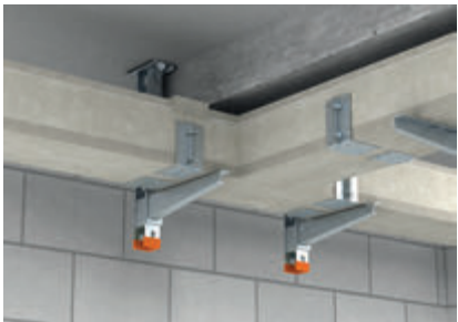
Предварительно смонтированные стандартные фасонные детали в трассах.
