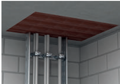
Прочная установка блоков в от- верстии в перекрытии.
