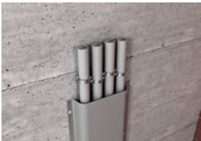
Крепление бандажа с помощью металлических реек при монтаже с дистанционными скобами.
