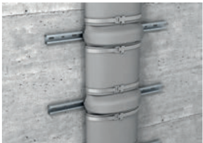
Крепление бандажа с помощью металлических монтажных лент и реек.
